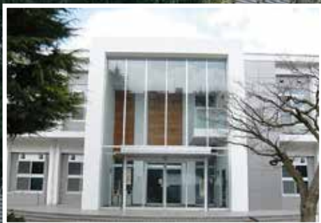
C棟正面入口
