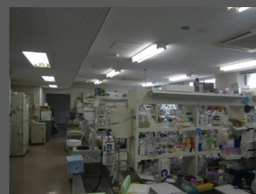
着工前写真（実験室内観）
