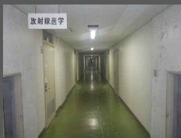
着工前写真（廊下内観）
