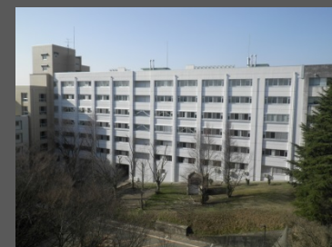
完成写真（外観）
