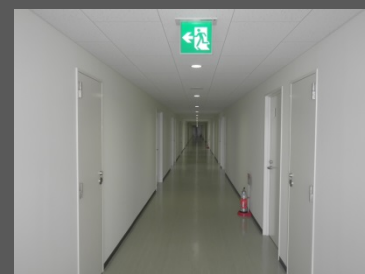
完成写真（廊下内観）
