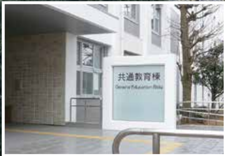
正面玄関 (A棟)
