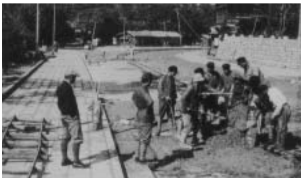
国道舗装工事
